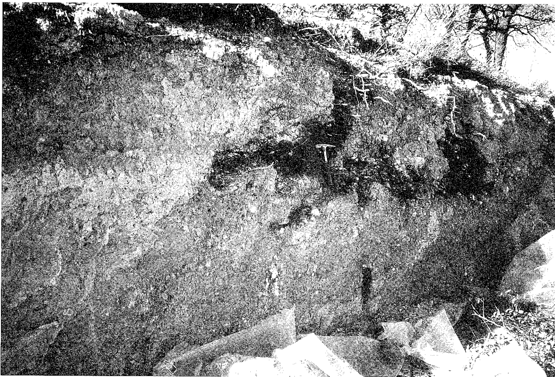
Fig. 18 - Particolare della foto precedente (sbancamento sul glacis) mostrante il pezzame caotico del corpo di frana, costituito da Scaglia rosata, variegata, cinerea e paleosuolo (indicato dal martello).
