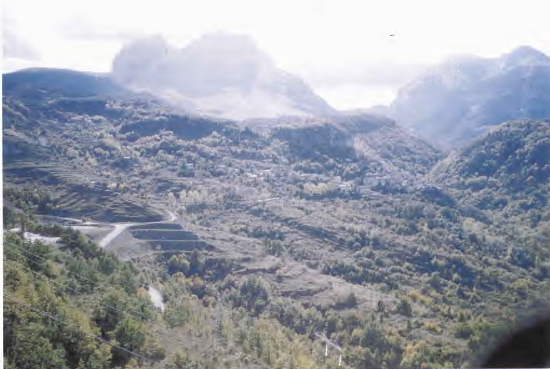
Fig. 5 - Panoramica della frana di Pietracamela
