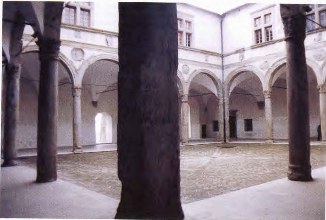
Fig. 1 - La "Loggia Magna" è il porticato principale scoperto del Palazzo Ducale di Camerino. I processi di alterazione dell'arenaria hanno interessato, in varia misura, sia le strutture architettoniche e decorative che le colonne.
