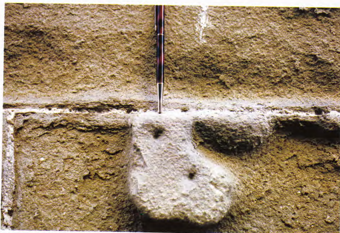
Fig. 5 - Particolare ravvicinato mostrante la formazione di "superfici di sfaldamento", che si formano in maggior quantità nei blocchi a maggior contenuto in minerali argillosi.
