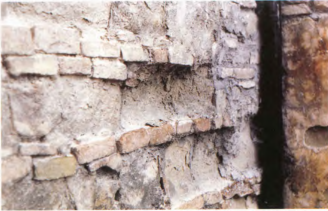
Fig. 6 - La presenza del laterizio evidenzia l'avvenuta azione dell'alterazione superficiale con formazione di significative rientranze.
