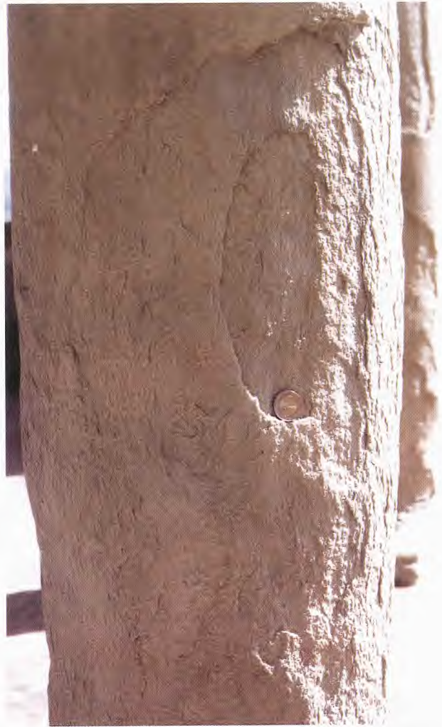
Fig. 3 - Particolare di una colonna ove è ben visibile la desquamazione con distacco di superfici concentriche all'asse della colonna. L'azione è maggiormente evidente nella esposizione a Sud.
