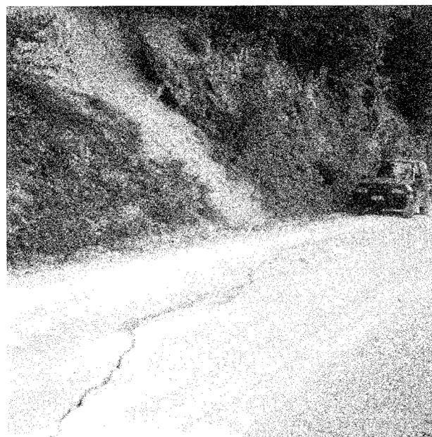
Fig. 7 - Frattura lungo la strada in località La Pintura. Sullo sfondo è possibile individuare un piano di faglia preesistente che interessa i depositi di versante tardo-pleistocenici.
