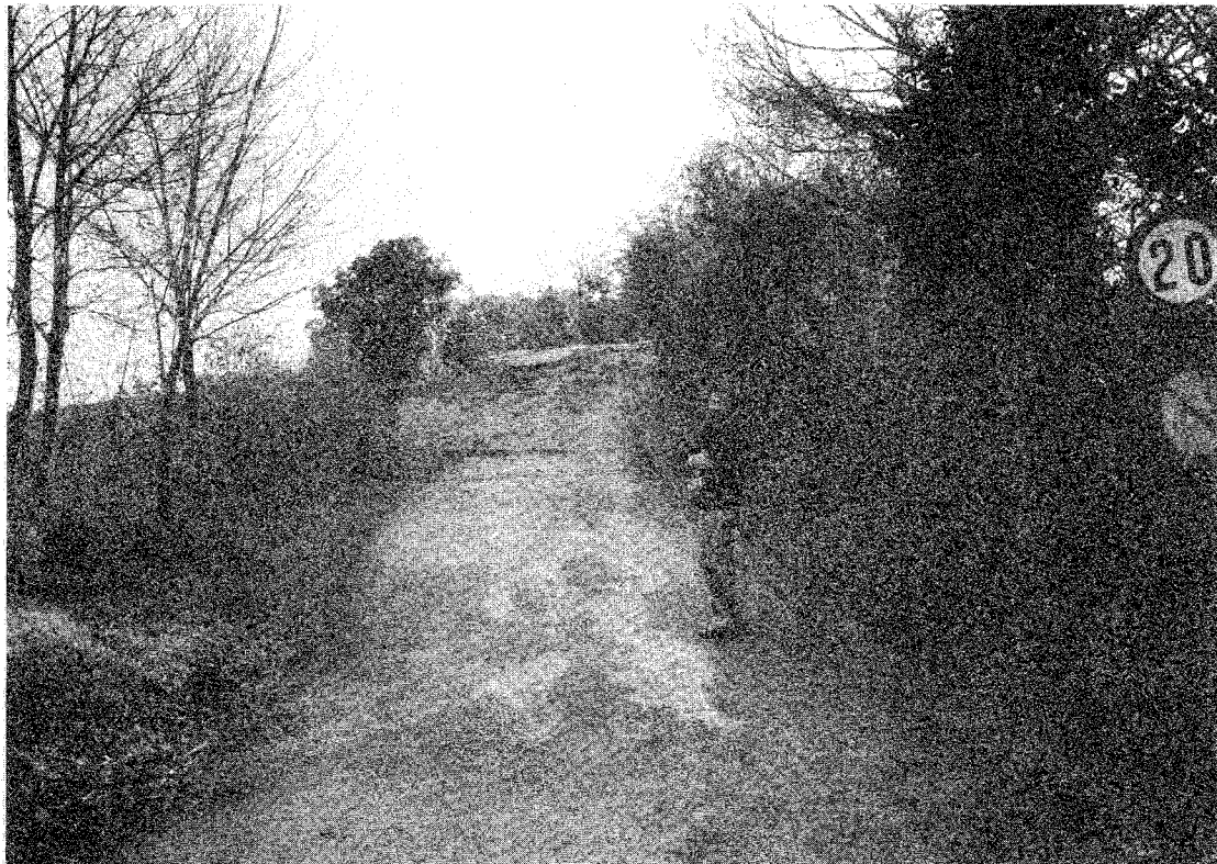
Fig. 4.5 - Strada di Artida dislocata lungo la scarpata superiore. Artida road displaced along the main scarp.
