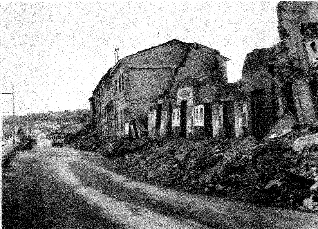
Fig. 4.11 - Edifici dissestati al piede della frana ad est di Borghetto. Damaged buildings at the foot of the landslide to the east of Borghetto.
