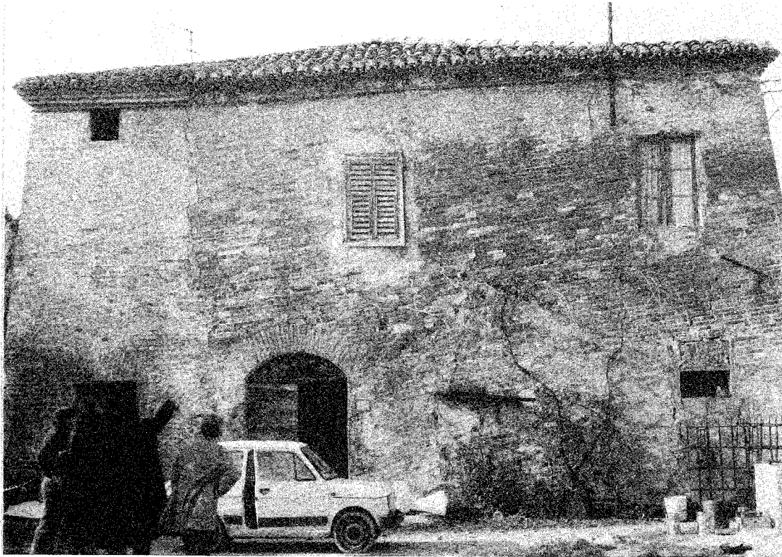
Fig. 4.8 - Casa postale del XVII secolo all'interno della trincea inferiore con evidenti segni di antiche rotazioni e riadattamenti. Posthouse of the XVII sec. inside the lower trench showing evidente sign of antique tilting and reconstructions.
