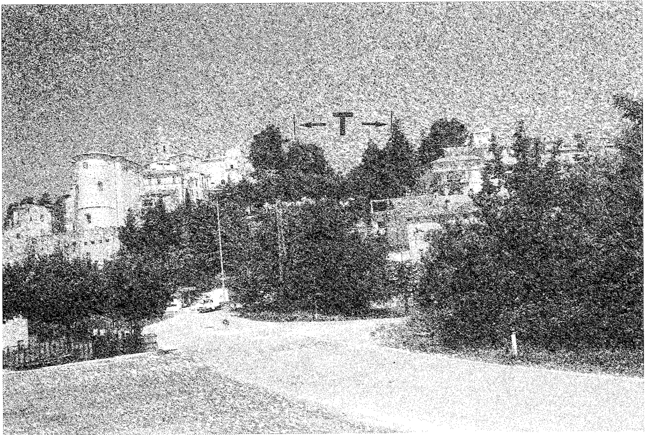
Fig. 9 - Trincea (T) ad andamento nord-sud, connessa a scorrimento traslazionale che divide in due porzioni l'abitato di Montelparo.
